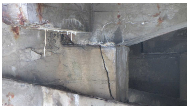
Obr. 4 Lokálne porušenie v ložiskovej oblasti V. poľa
